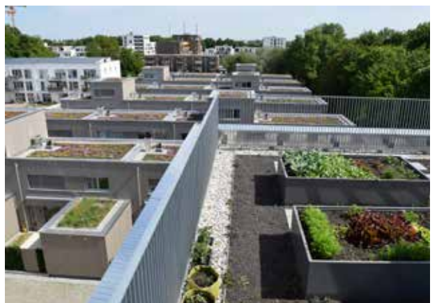
Abb. 17: In 2019 wurden 83,5 % Extensiv- (im Bild links) und 16,5 % Intensivbegrünungen (im Bild rechts) ausgeführt. Quelle: BuGG
