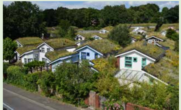
Abb. 26: Schon vor Jahrzehnten wurden ganze Wohnsiedlungen komplett „dach-begrünt“ wie hier in Düsseldorf. Quelle: BuGG
