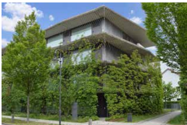
Abb. 32: Bodengebundene Fassadenbegrünungen mit Netzen bzw. Gittern lassen sich gut erfassen ... Quelle: BuGG
