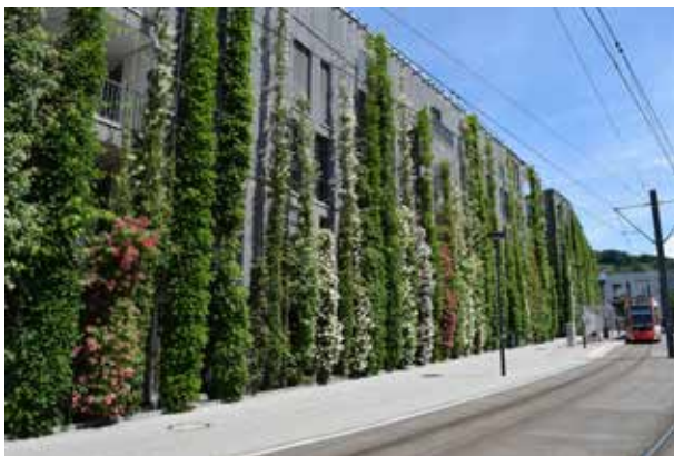
Abb. 6: Bodengebundene Fassadenbegrünung mit Kletterhilfe. Quelle: BuGG
