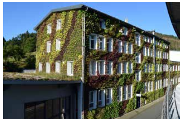
Abb. 7: Wandgebundene Fassadenbegrünung, auch als „Living Wall“ bezeichnet. Quelle: BuGG
